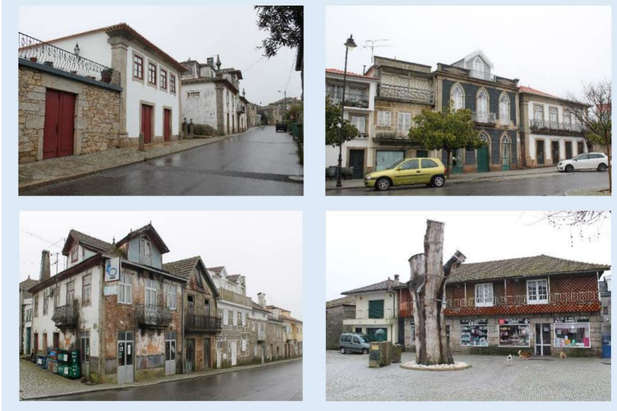
Figura 19 | Estado de conservação e dissonâncias do edificado na ARU de São Martinho de
